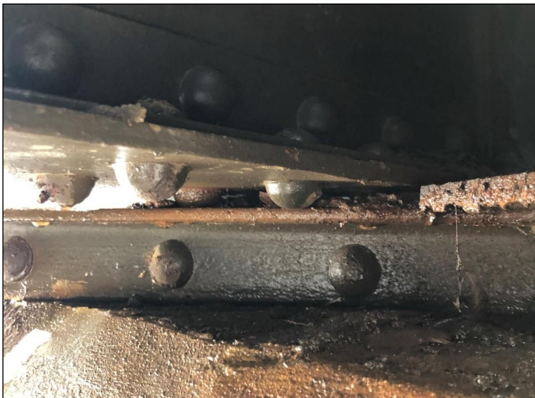
Foto 25: Detail opření ztužidla do úložného prahu na opěře O1
