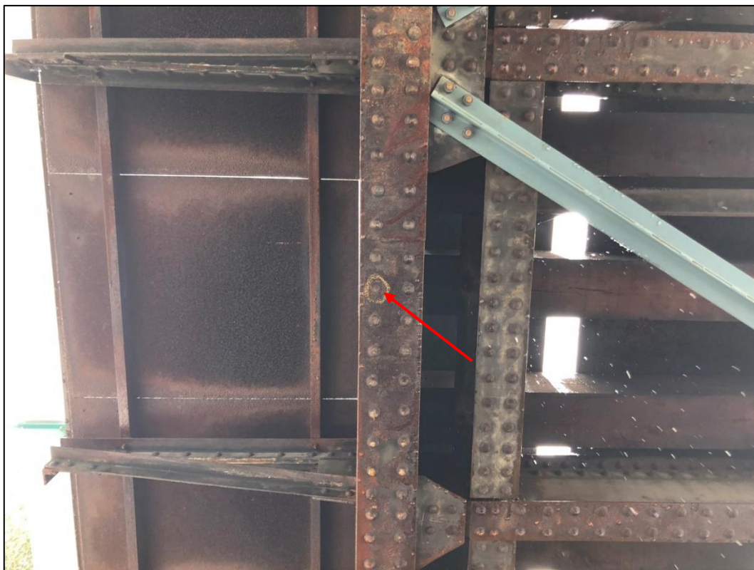
Foto 7: Pohled na spodní líc NK u opěry O1, druhé pole, pravá část, ulomená hlava nýtu
