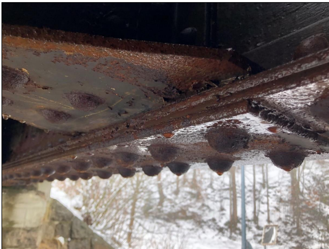
Foto 38: Spodní pohled na spodní líc pravého hlavního nosníku, plošná koroze
