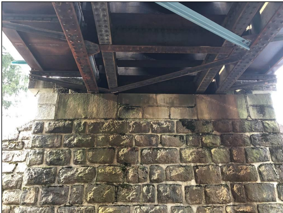
Obr. č. 11 – pohled na nosnou konstrukci a část opěry Tanvald
