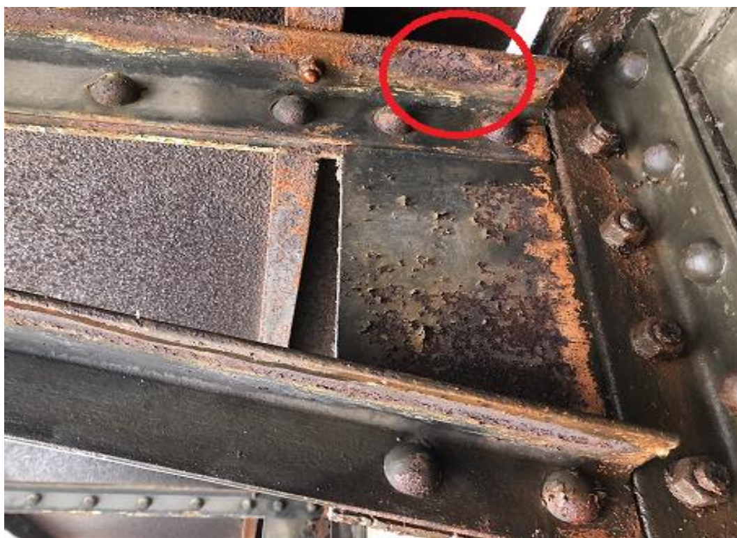
Obr. 11: Lokalizace odběru korozních produktů z horní pásnice příčného ztužení
