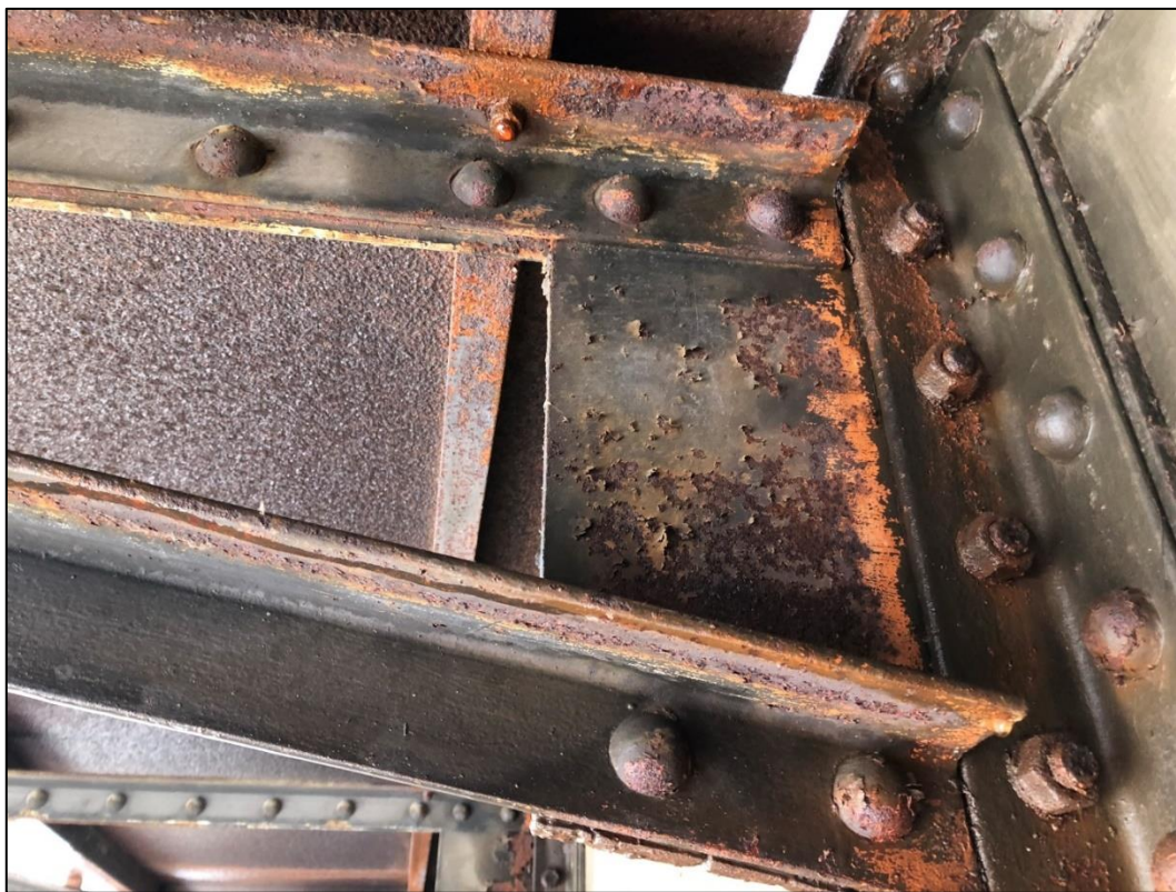
Foto 21: Detail koroze spojovacího plechu konzol
