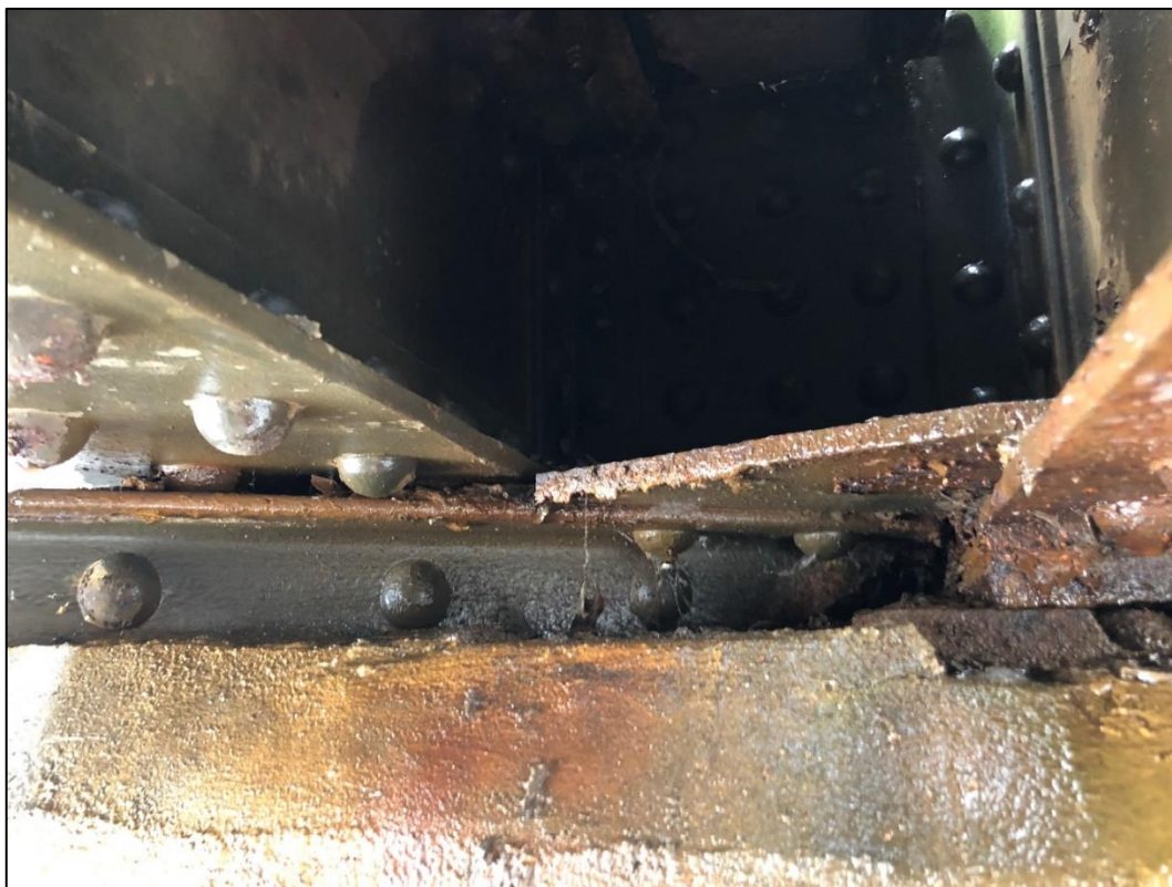
Foto 24: Pohled na ložisko na levé straně na opěře O1
