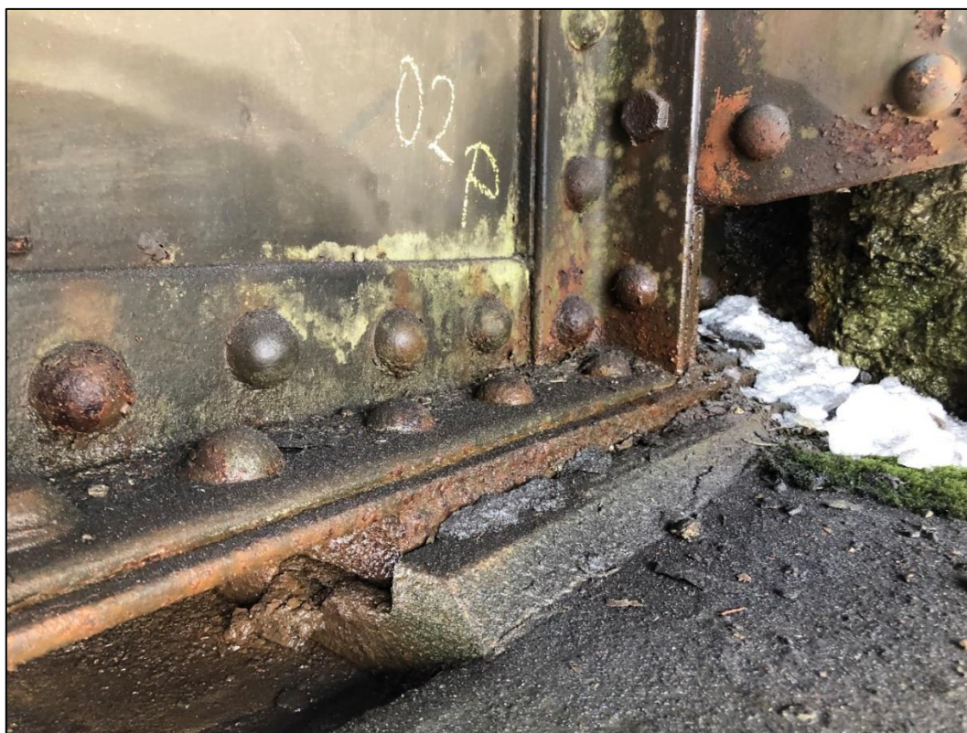
Foto 19: Detail ložiska na opěře O2, vpravo
