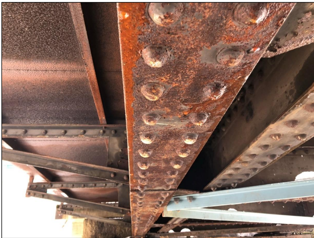
Foto 23: Detail stavu spodního líce levého hlavního nosníku
