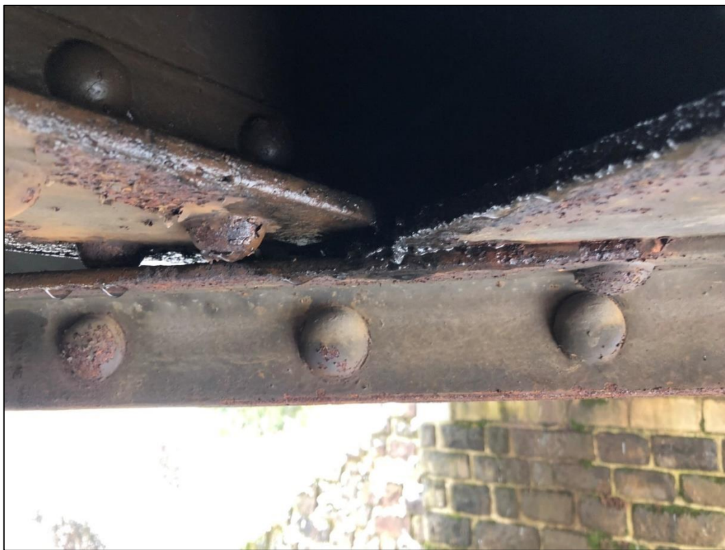
Foto 33: Detail styčnickových plechů, plošná koroze
