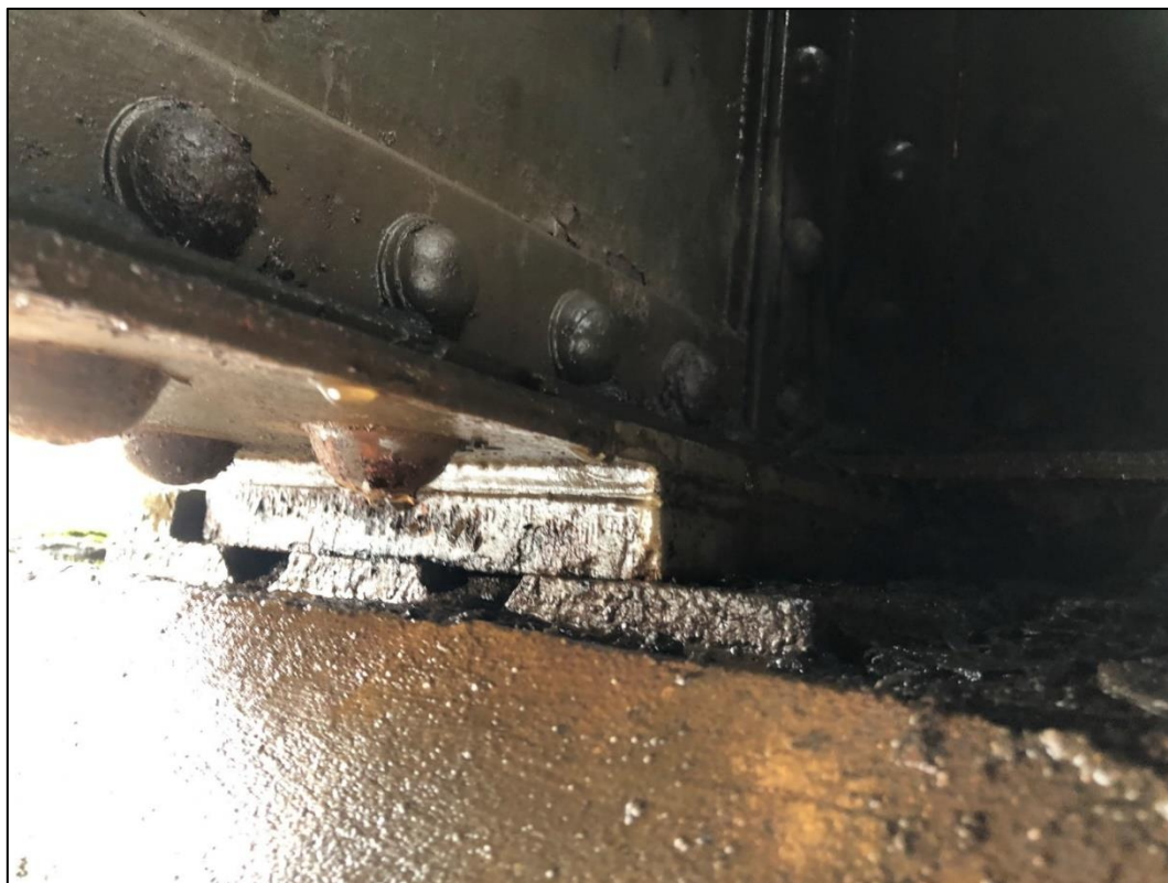
Foto 28: Pohled na ložisko na pravé straně na opěře O1
