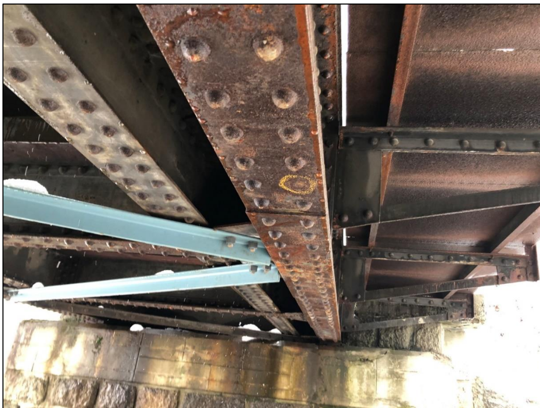
Foto 37: Detail odlomené hlavy nýtu na pravém hlavním nosníku
