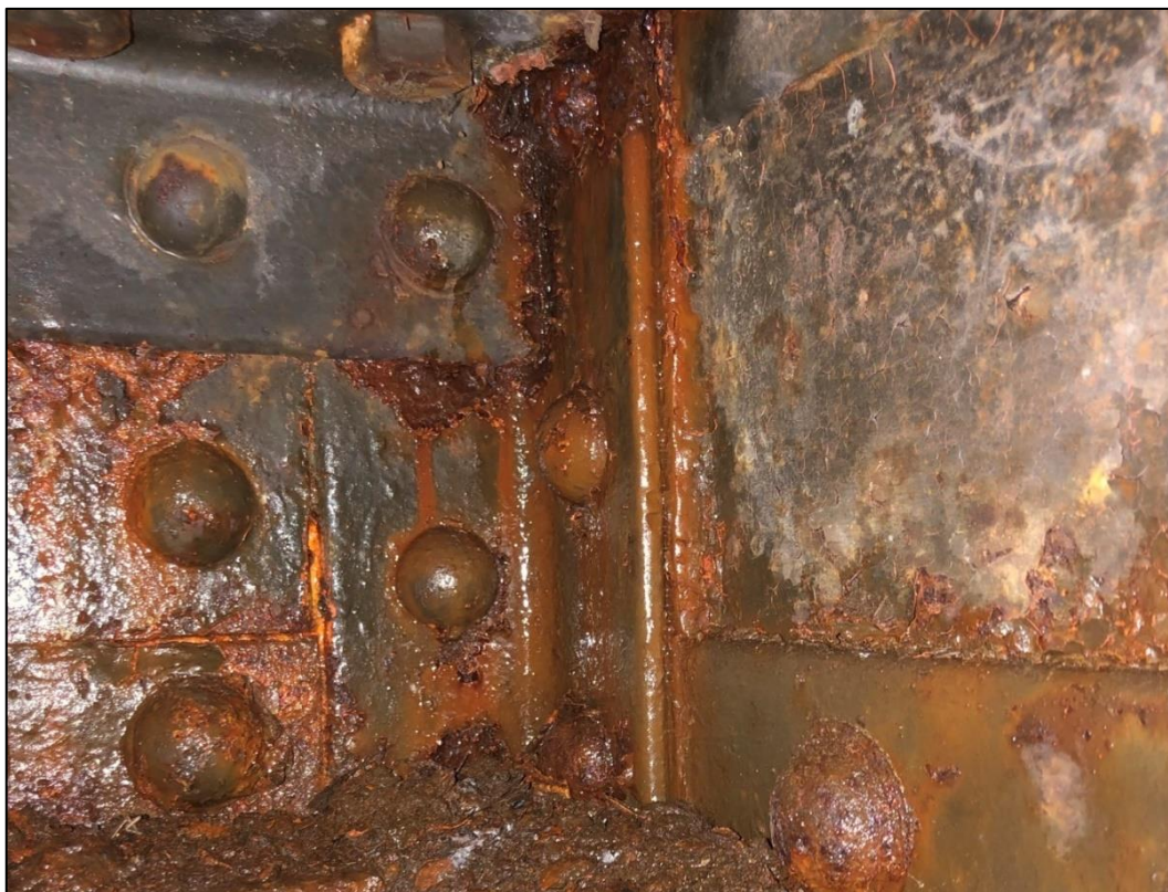
Foto 40: Detail napojení příčnicku na hlavní nosník, plošná koroze, znečištění
