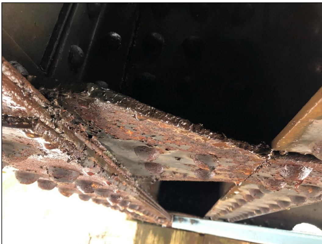
Foto 26: Detail spojovacího plechu příčnicku a podélníku, plošná koroze
